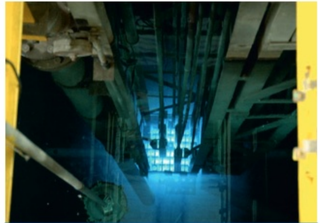
चित्र -2 स्विमिंग-पूल-टाइप अनुसंधान रिएक्टर 'अप्सरा' की सुंदर नीली चमक (चेरेंकोव विकिरण)
