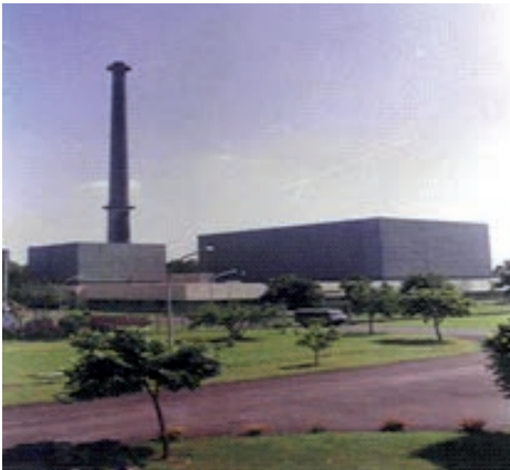
Waste Immobilisation Plant, Tarapur
